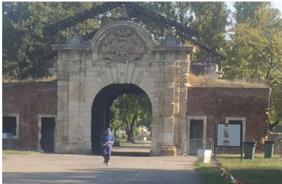
Varje varv sprang löparna genom Karlo VI:s port, en del av borgen Kalemegdan.
